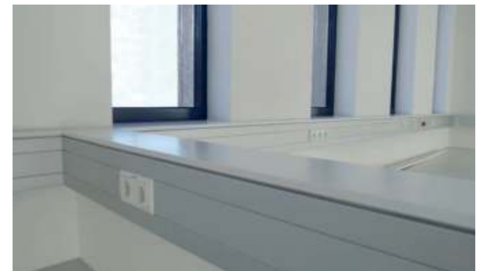
linea 150M mit Schattenfuge auf Kabelkanal
