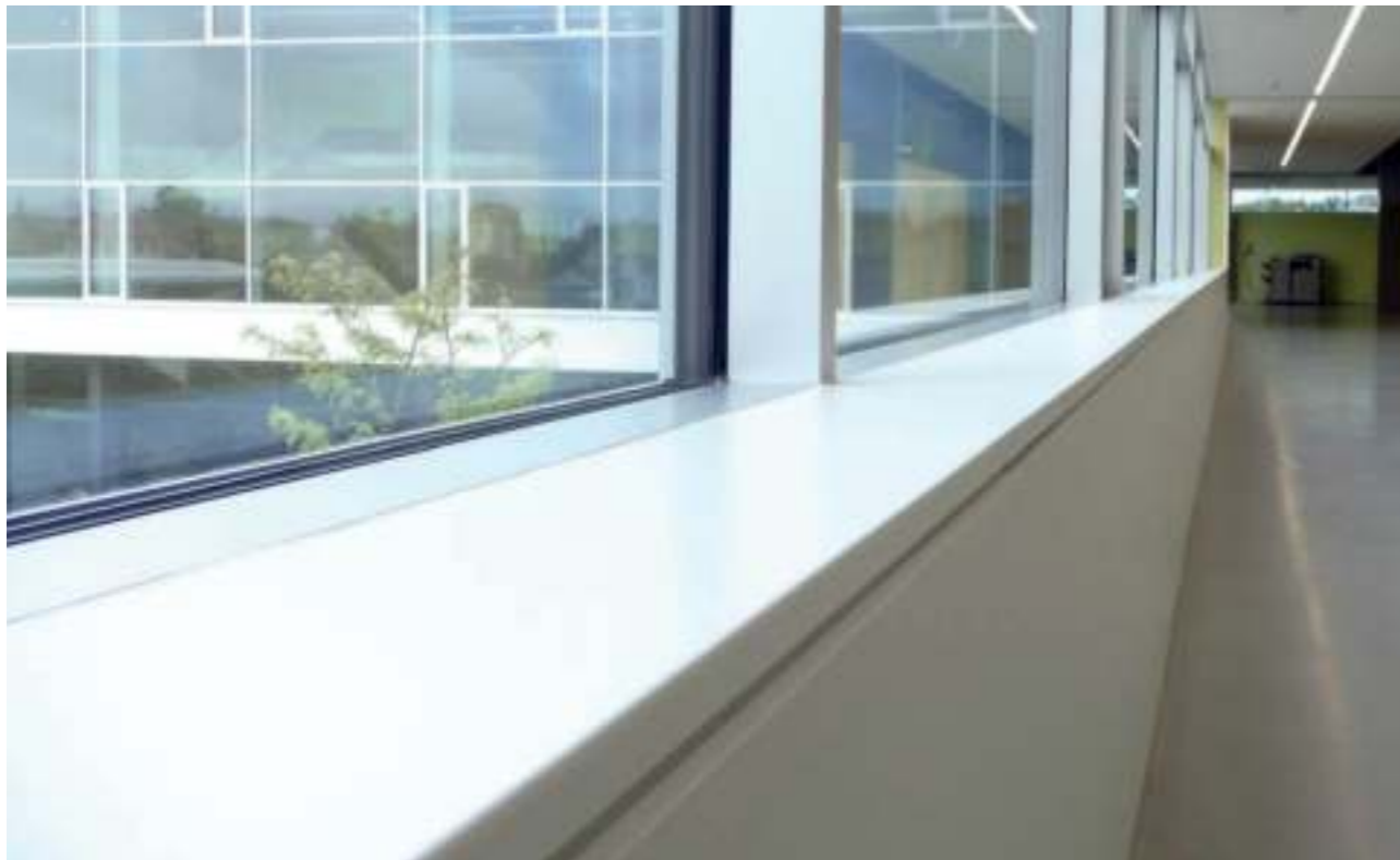
stumpfe Anbindung mit Anschlussprofil
